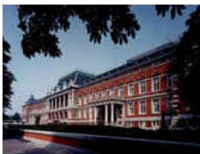
中央合同庁舎第6号館赤レンガ棟
