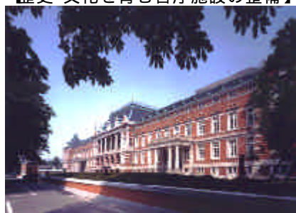
中央合同庁舎第6号館赤レンガ棟
