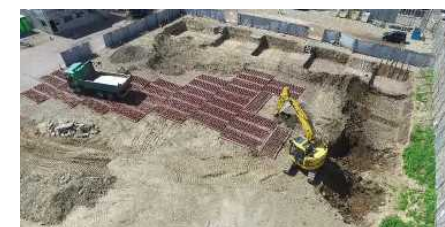
ICT建築土工 本工事での掘削積込
