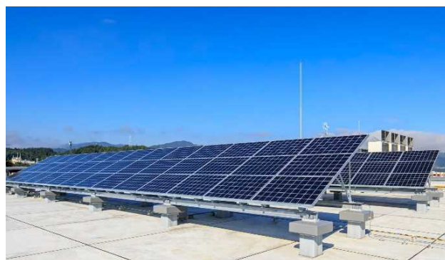
<高山地方合同庁舎>
