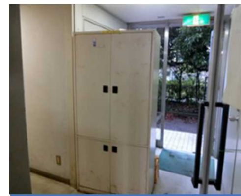
避難出口付近の障害物
