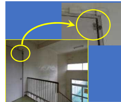
防火扉の施錠
