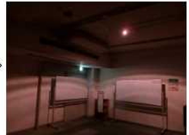
誘導灯+非常用照明を点灯
