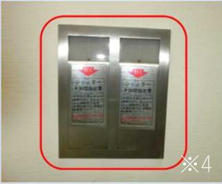
※4<br>手動閉鎖装置
