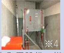
※4<br>自家発電設備の燃料槽                                                                                                       | 電気設備の部屋には、キュービクル式高圧受変電設備室（発電所から変電所を通して送られてくる6,600 Vの電気を100 Vや200 Vに降圧する受電設備を収めた金属製の箱）や、自家発電設備室などがある。                                            |
