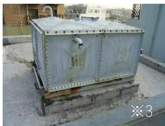
給水タンクの腐食の事例
