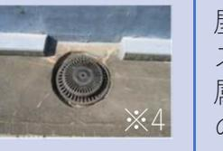
※4<br>屋上排水口(ドレン)            | 屋根（屋上）の仕上げには、シート防水や、アスファルト防水、塗膜防水、鋼製屋根（長尺金属板葺や折版葺など）があり、建物内部への水の進入を防ぐ役割を持つ。                                                                     |
