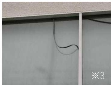
建具周囲のガスケットの外れの事例
