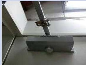
ヒューズタイプ | 随時閉鎖式防火扉は、平常時は開放状態で用い、火災時のみ閉鎖する。火災を感知して自動で閉鎖する煙感知器連動タイプや、熱で閉鎖するヒューズタイプなどがある。 |
