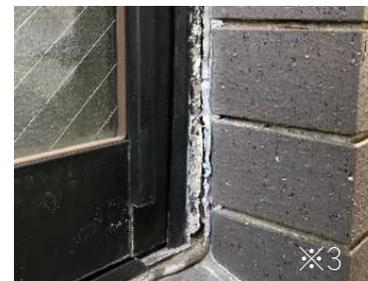
建具周囲のシーリングのひび割れの事例
