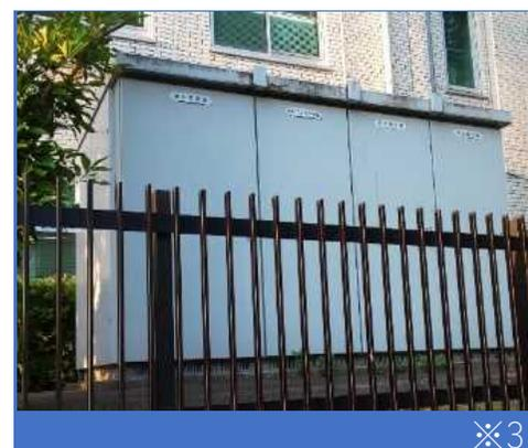
受変電設備の腐食
