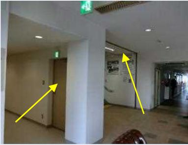
常閉防火扉と防火シャッター                                                                                     | 常時閉鎖式防火扉は、平常時より常に閉鎖状態となる。そのため、火災時の火炎や煙の流出や拡大防止には非常に効果的である。                   |
