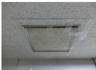
天井点検口の脱落の事例
