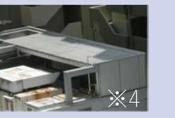
※4<br>鋼製屋根<br>
