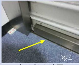
※4<br>危害防止装置 | <p>防火シャッターは、平常時は開放状態で用い、火災時に閉鎖する。</p> <p>防火シャッターには、「自動式」と「手動式」があり、自動式は煙感知器と連動して自動でシャッターが降り、手動式は手動閉鎖装置の非常ボタンを強く押すことにより作動する。</p> <p>現在の防火シャッターには、挟まれ防止のため、障害物を感知して降下を停止する危害防止装置が設けられている。</p> |
