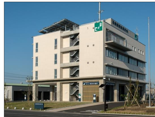
津波対策を実施した庁舎の例 (石巻港湾合同庁舎)
