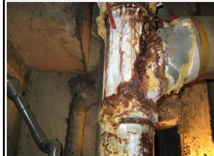
排水管の腐食により漏水が発生し、配管改修が必要
