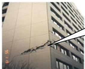
柱が破断するなど構造体が損傷し、機能の復旧に時間を要した
