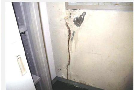
外壁クラックから漏水が発生し、外壁・内部改修が必要
