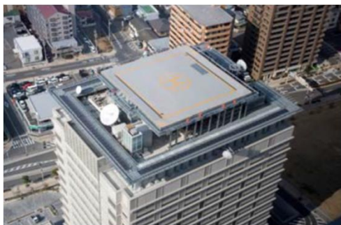
屋上ヘリポート
