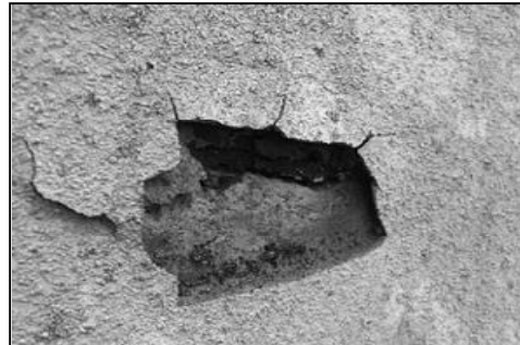
鉄筋の腐食
