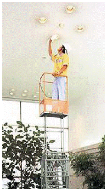
照明器具清掃作業 1)
