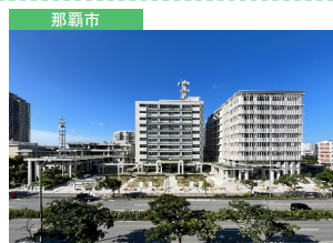
那覇第2地方合同庁舎 (沖縄県那覇市)
