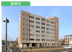
長岡地方合同庁舎 (新潟県長岡市)
