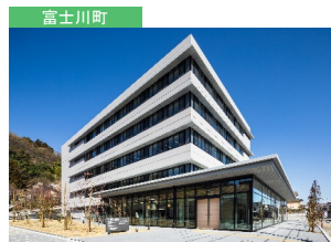
富士川地方合同庁舎 (山梨県南巨摩郡富士川町)
