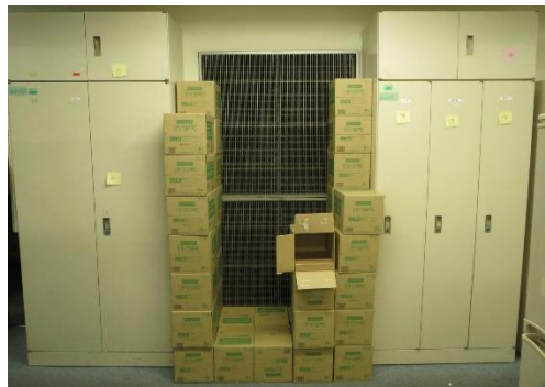
ダンボール箱により閉塞された還気用ガラリ
