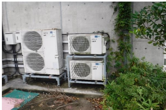
屋外設備機器周りの雑草の状況
