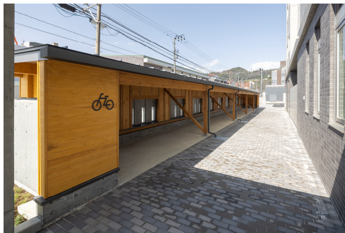
<福島第二地方合同庁舎（自転車置場）>
