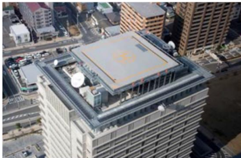
屋上ヘリポート
