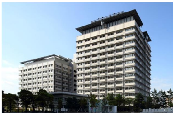
(高松サポート合同庁舎)
