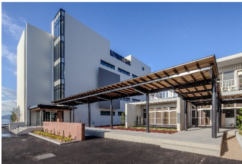
写真3 海上保安大学校 渡り廊下
