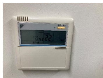
全熱交換ユニットリモートコントローラ
