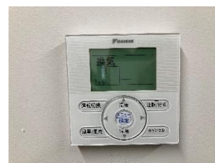
パッケージ形空気調和機用 リモートコントローラ
