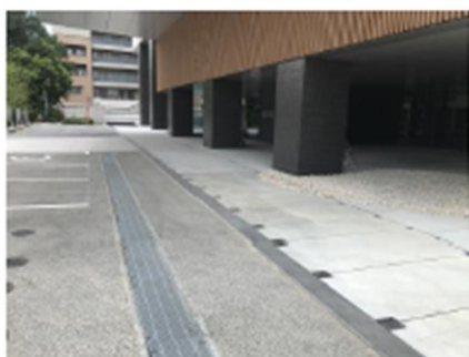
南面外構 床エキスパンション 全景
