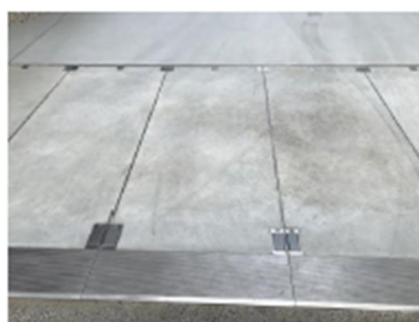
南面外構 床エキスパンション 全景
