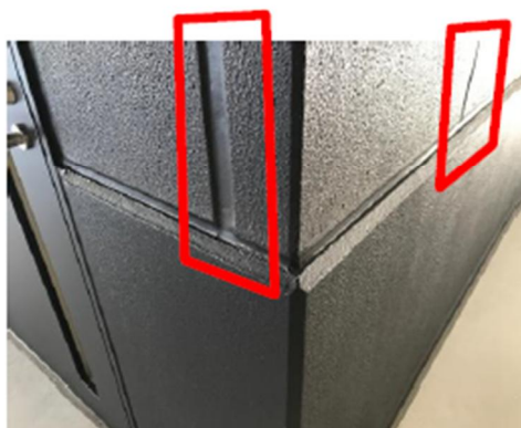
外部 ALC 壁板間シール
