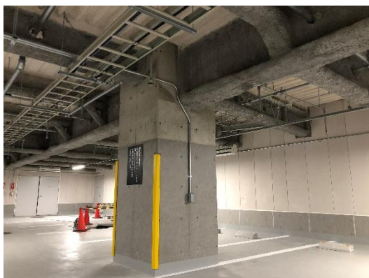
柱及び梁 (地下1階)
