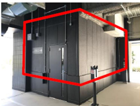
外部 ALC 壁板間シール
