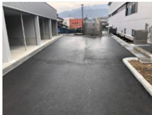
来庁者用通路仕上げ（アスファルト舗装）
