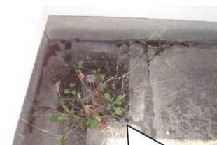
屋上の雨水ドレンの目詰まりを除去する。
