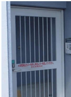
避難階段進入口
