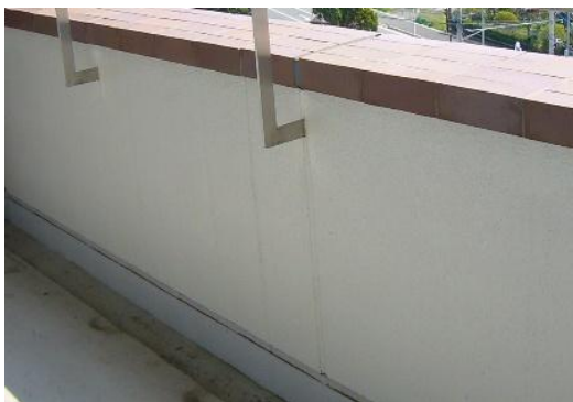
バルコニー手すり壁（サイディング）
