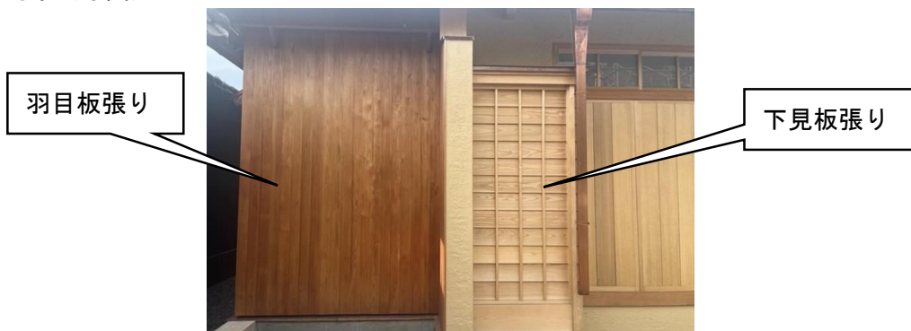
外壁（木製板張り）
