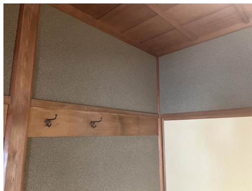
内部壁（小舞壁塗り）
