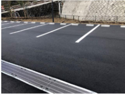
来庁者用駐車場仕上げ（アスファルト舗装）
