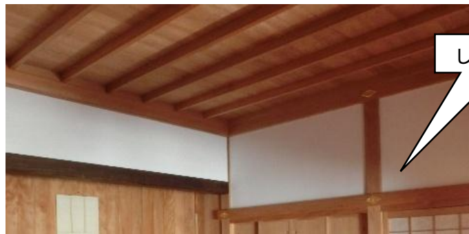
内部壁（しっくい塗り）
