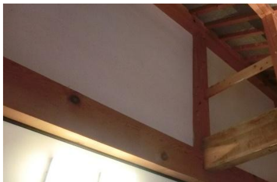
内部壁（ドロマイト plaster 塗り）
