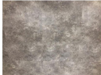
置敷きビニル床タイル
