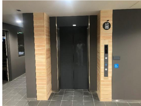
エレベーター出入口
