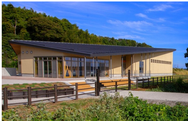
涸沼水鳥・湿地センター(茨城県茨城町) 展示施設(木造化)
