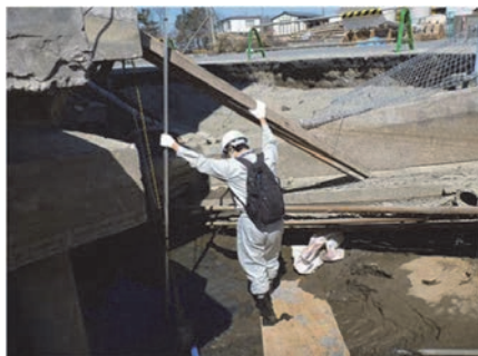
▲ 官庁施設の被災状況調査
