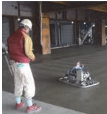
施工合理化技術の導入促進(例:コンクリート床仕上げロボット)
