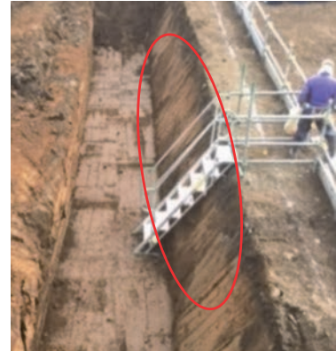
IoT建築土工を活用した施工
