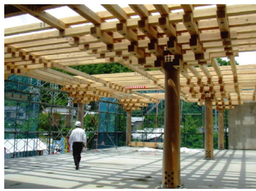
井桁建て方完了(上棟式開催)
