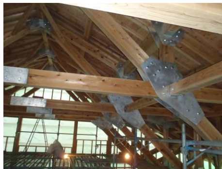
プレイルーム小屋組状況
