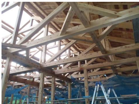
高等部小屋組状況
