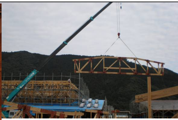
同 梁架設状況
