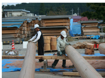
地元大工による丸太加工
