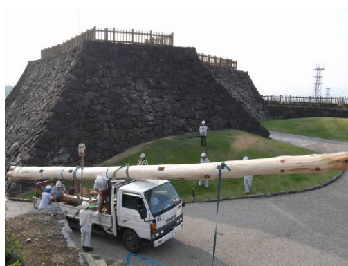
搬入風景 重機による冠木梁の搬入
