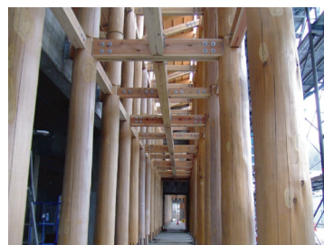
1 階廊下のフレーム
