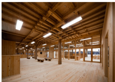
管理棟 2 階多目的ホール(井桁工法)
