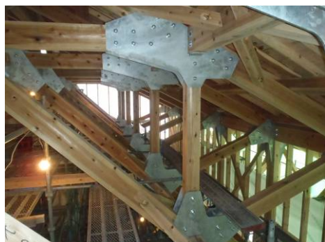
柱と梁・桁・筋違の交差部
