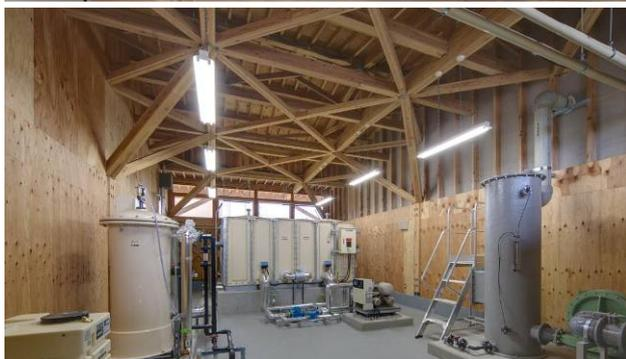
高さのある設備機器の設置及び機器更新の容易さに配慮し、柱から4束立てで屋根を支えている。これにより、頭つなぎ梁や筋かいの数を減らしている。
