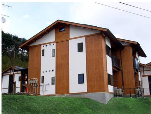
↑ 外壁の茶色部分が大断面（大型）集成材パネル
