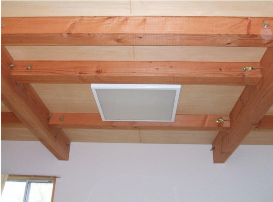
薄型でシンプルなデザインの照明器具を選択し小梁の高さ程度に合わせている
