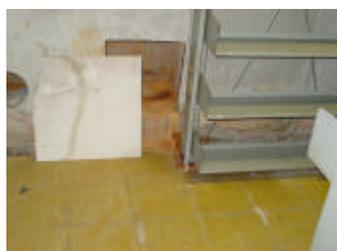
写真9 二重壁の点検口廻りの漏水跡
