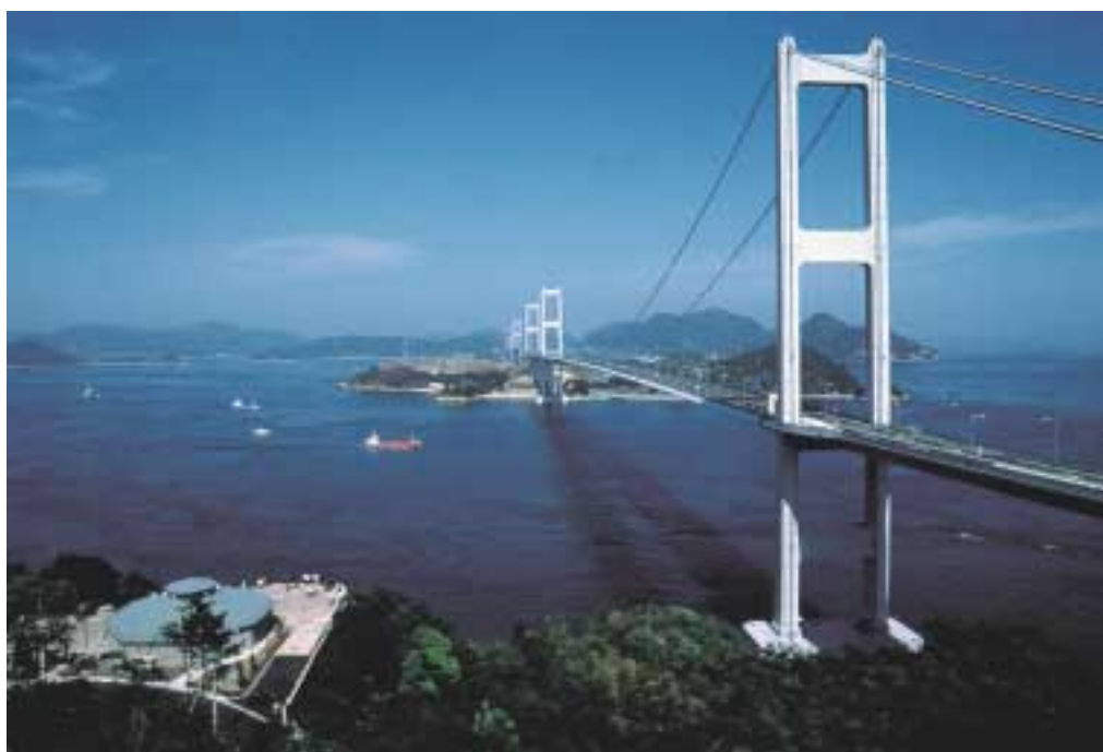
来島海峡大橋
