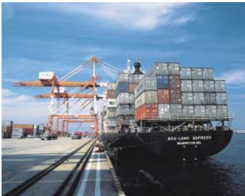
大水深コンテナバース（名古屋港）
