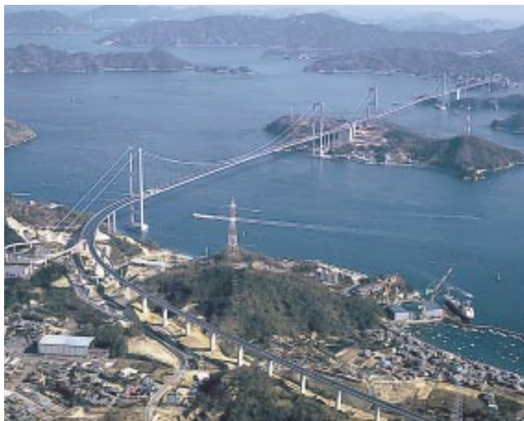
来島海峡大橋
