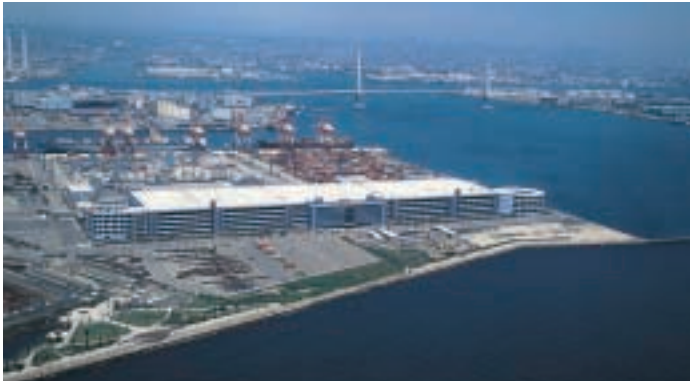
横浜港流通センター
