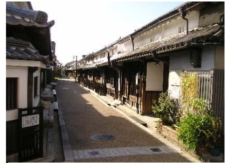
街なみ環境整備事業による住宅等の外観の修景、電柱の地中化等の実施事例【今井町地区（奈良県橿原市）】
