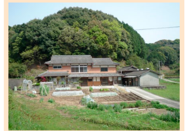
空き家バンク対象の家
