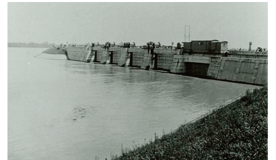
図表 1-1-12 完成当時の旧岩淵水門
