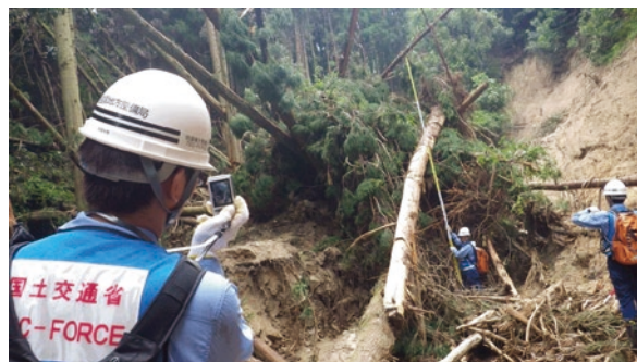
土砂災害危険個所の緊急点検（広島県広島市）
