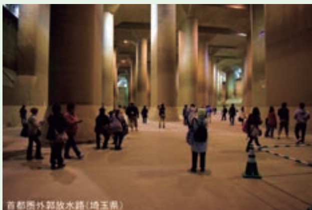
首都圏外郭放水路(埼玉県)
