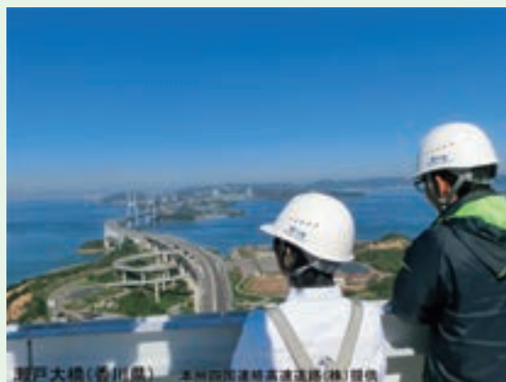
瀬戸大橋(香川県) 本州四国連絡高速道路(株)提供
