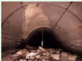
依山トンネル（県道）
