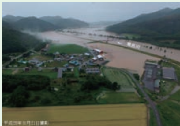
常呂川における被害状況
