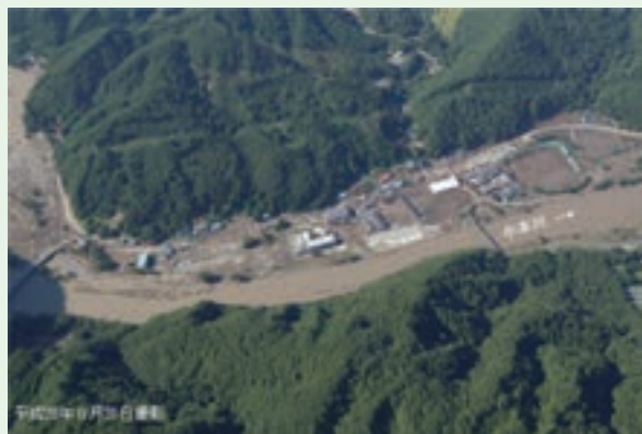
小本川における被害状況
