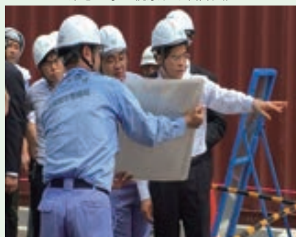
緊急工事を視察する石井大臣
