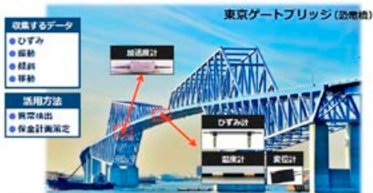
図表 I -2-1-13 東京ゲートブリッジ
