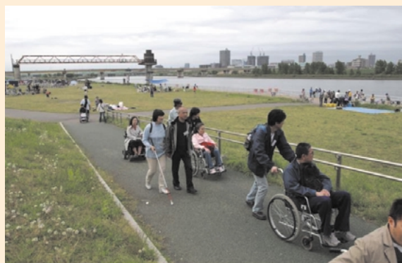
緩傾斜スロープの設置事例 (東京都荒川)
