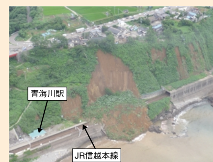
平成19年新潟県中越沖地震で発生した土砂災害（新潟県柏崎市）
