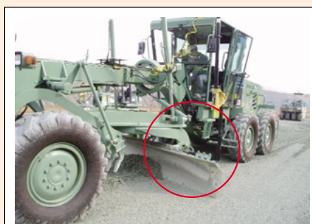
排土板を設計どおりに自動制御
