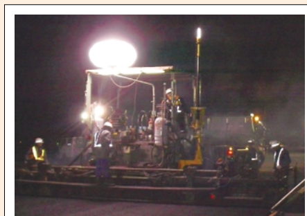
夜間でも精度の高い舗装工事
