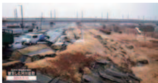
図表 I -1-2-3 河川堤防の仮復旧状況
