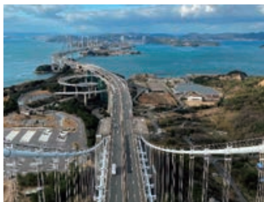
北備讃瀬戸大橋より岡山側を望む
