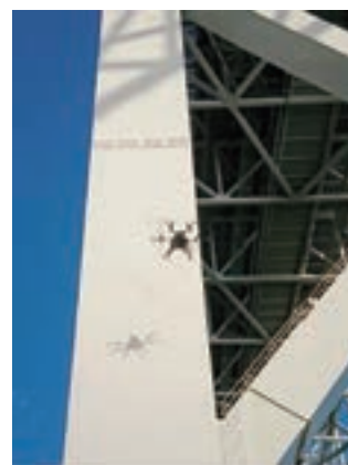
ドローンによる塗装点検手法の検討
