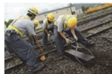
鉄道施設の修繕
