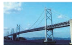
本四連絡橋（瀬戸大橋）
