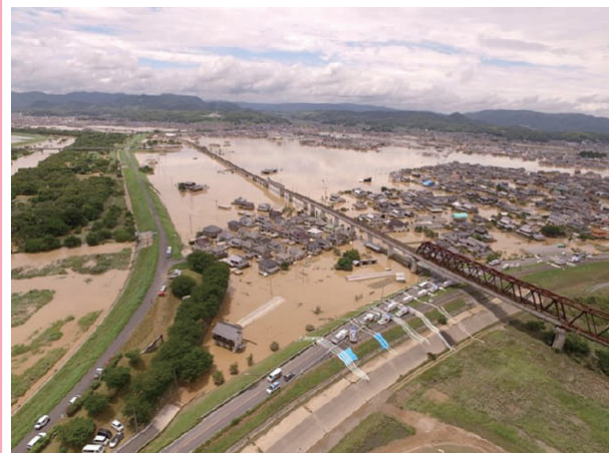
平成30年7月豪雨による被害 (岡山県倉敷市真備町の浸水状況)
