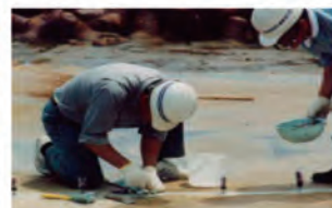
クラック補修状況（注入工）
